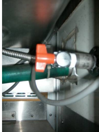
【モード切替弁】 タンクor水道直結 を選択 (右・赤いノブ)
